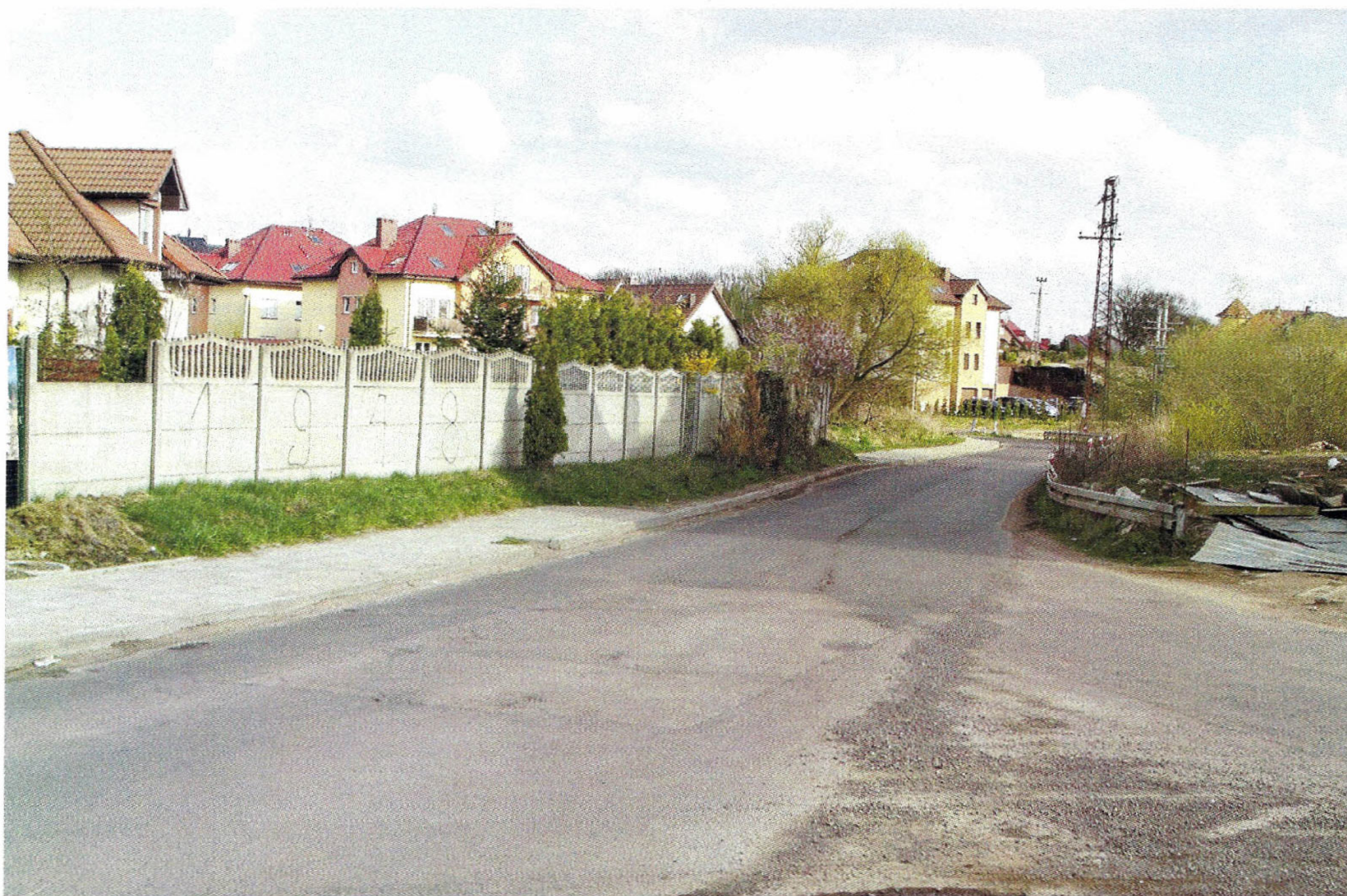
Fotografia 2 Urywający się chodnik przy skrzyżowaniu z ulicą Chłodną.
